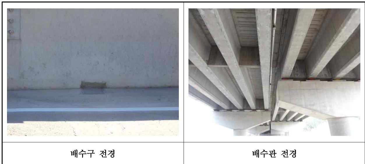
【사진 27.3.21】 배수시설 전경
