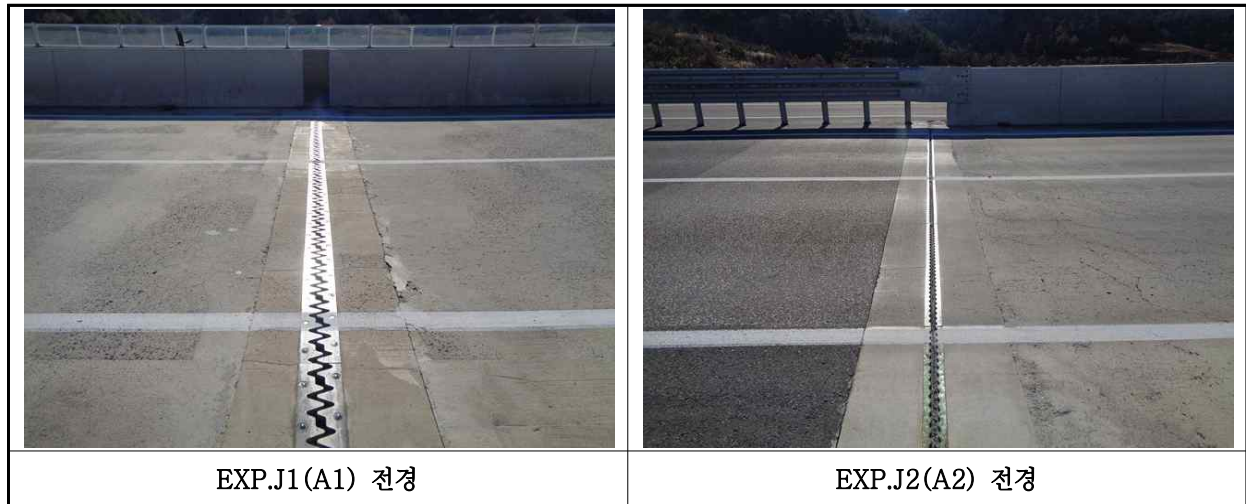
【사진 27.3.16】 신축이음장치 전경
