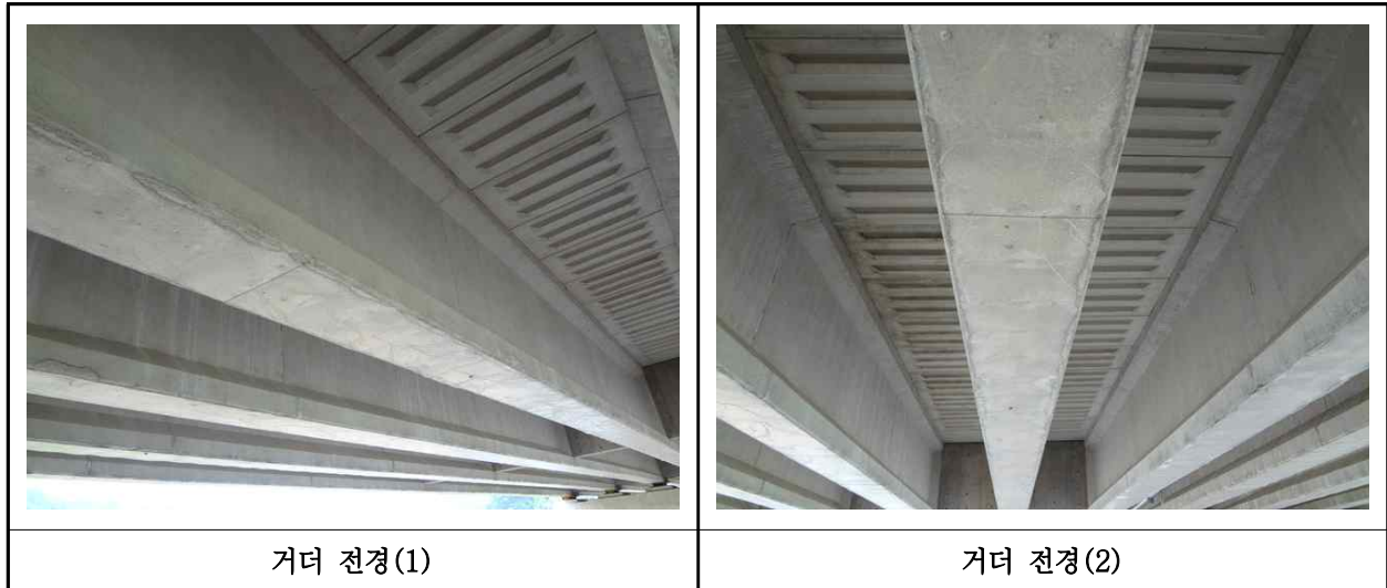
【사진 27.3.27】 거더 전경
