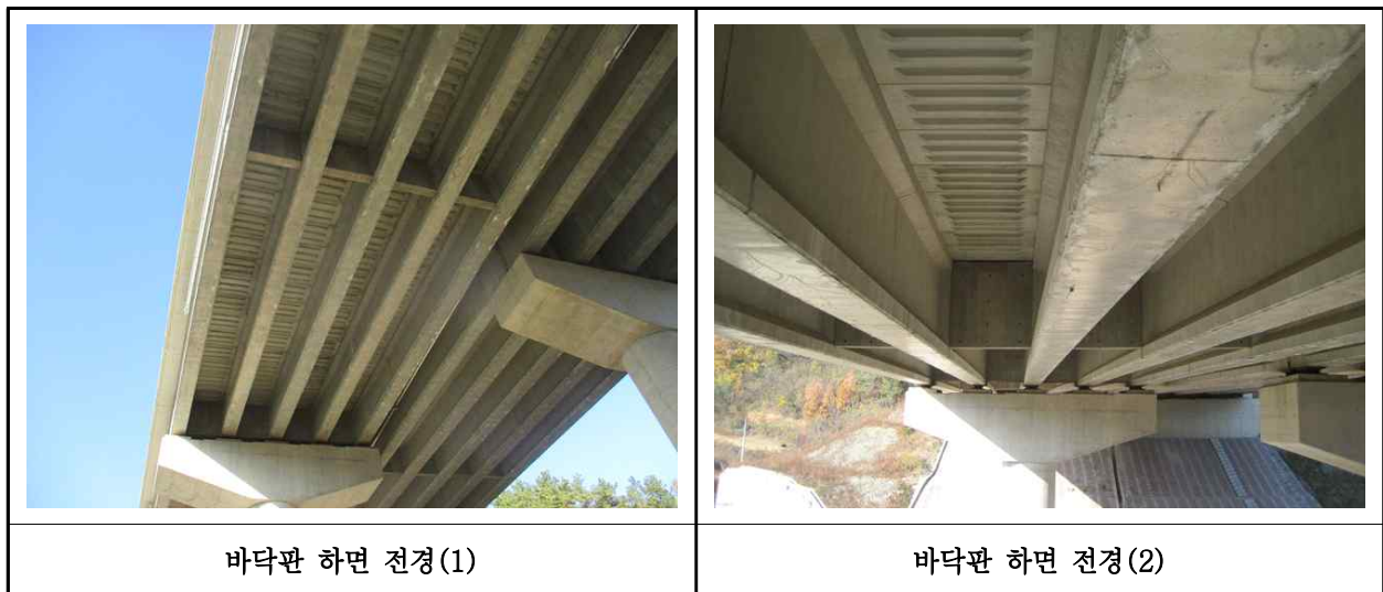
【사진 27.3.25】 바닥판하면 전경
