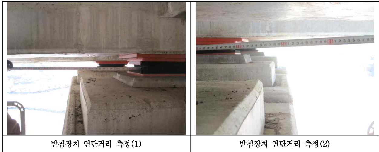
【사진 27.3.14】 교량받침장치 연단거리측정
