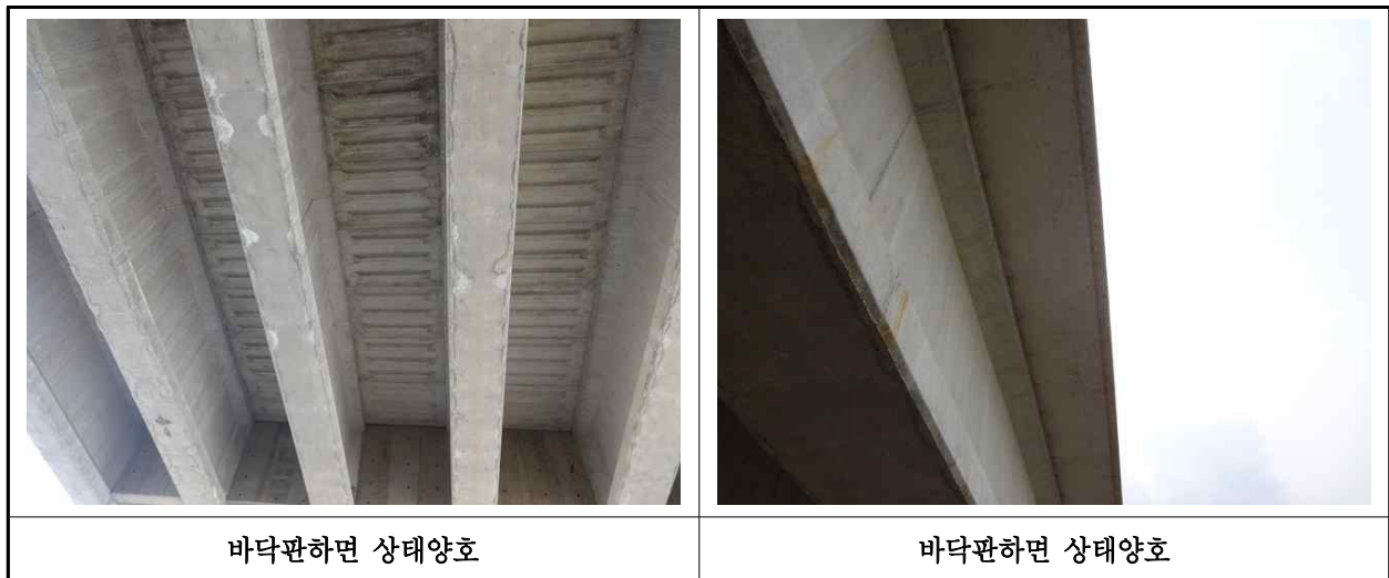
【사진 27.3.3】 바닥판하면 손상현황
