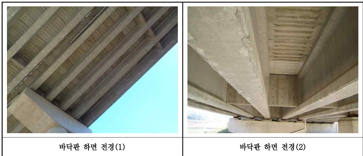
【사진 27.3.2】 바닥판하면 전경
