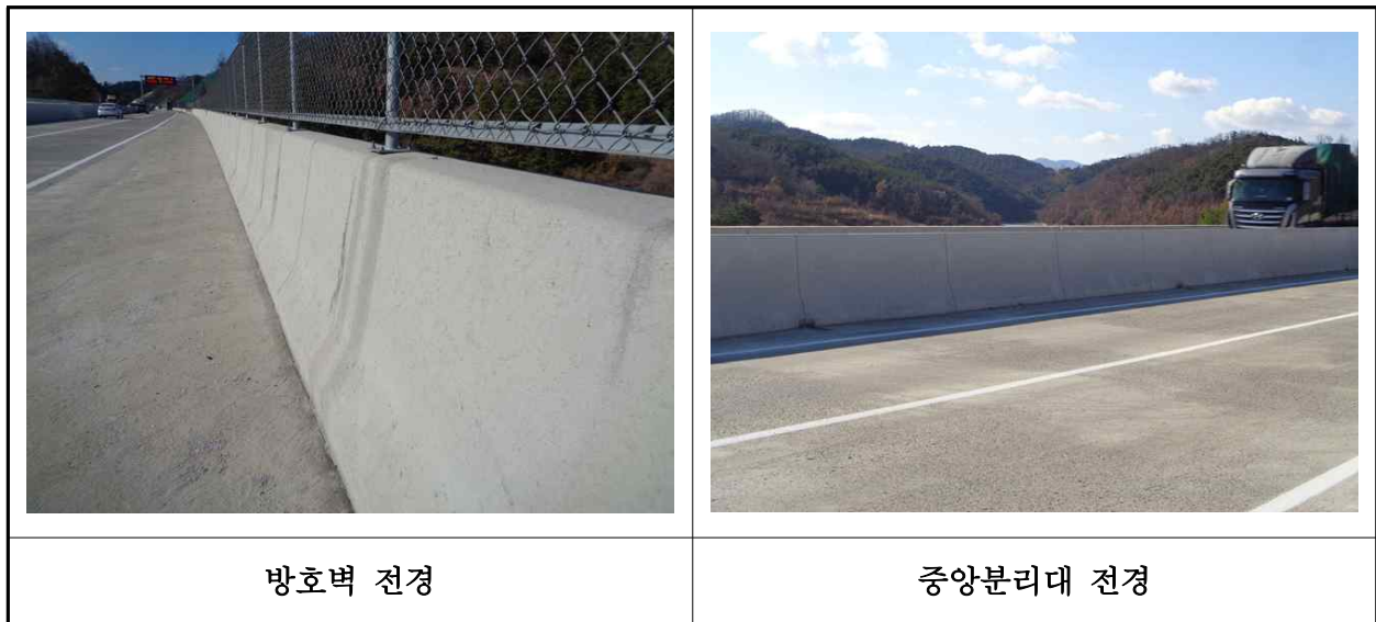
【사진 27.3.23】 방호벽 및 중앙분리대 전경
