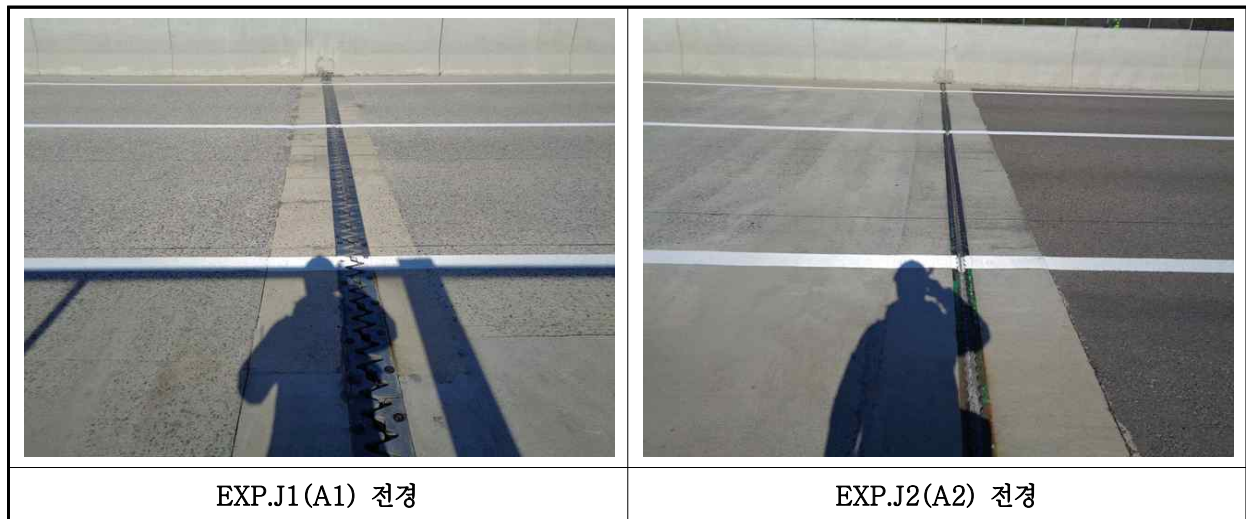
【사진 27.3.39】 신축이음장치 전경
