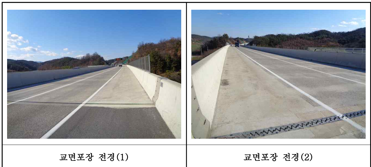
【사진 27.3.19】 교면포장 전경
