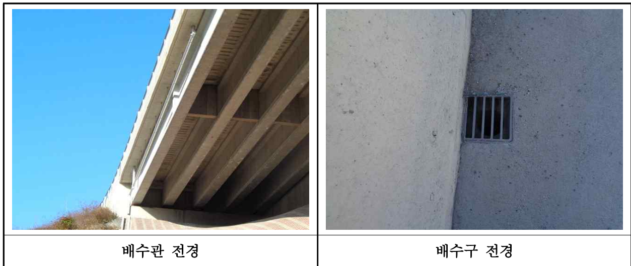
【사진 27.3.44】 배수시설 전경
