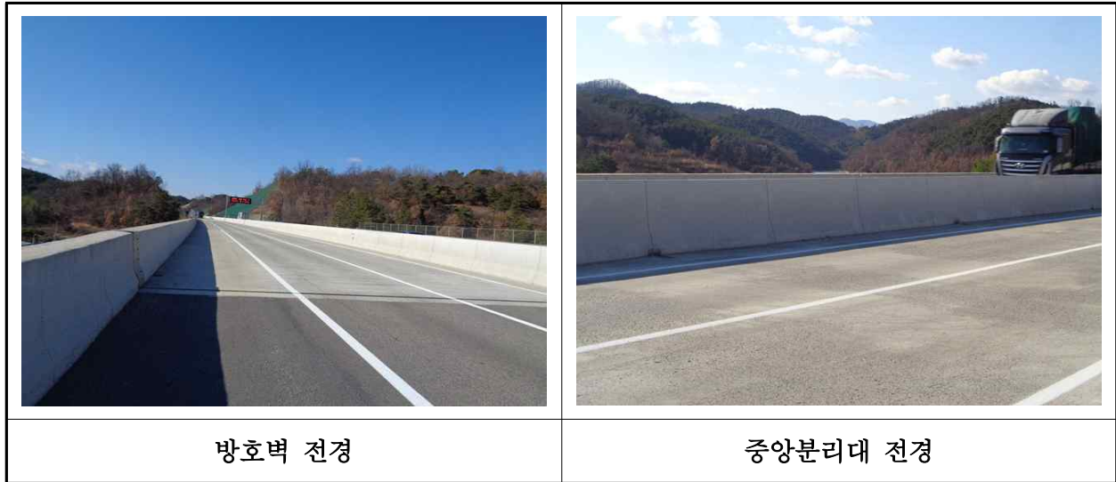
【사진 27.3.46】 방호벽 및 중앙분리대 전경
