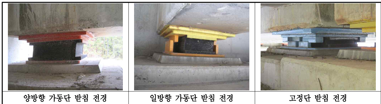
【사진 27.3.12】 교량받침 전경
