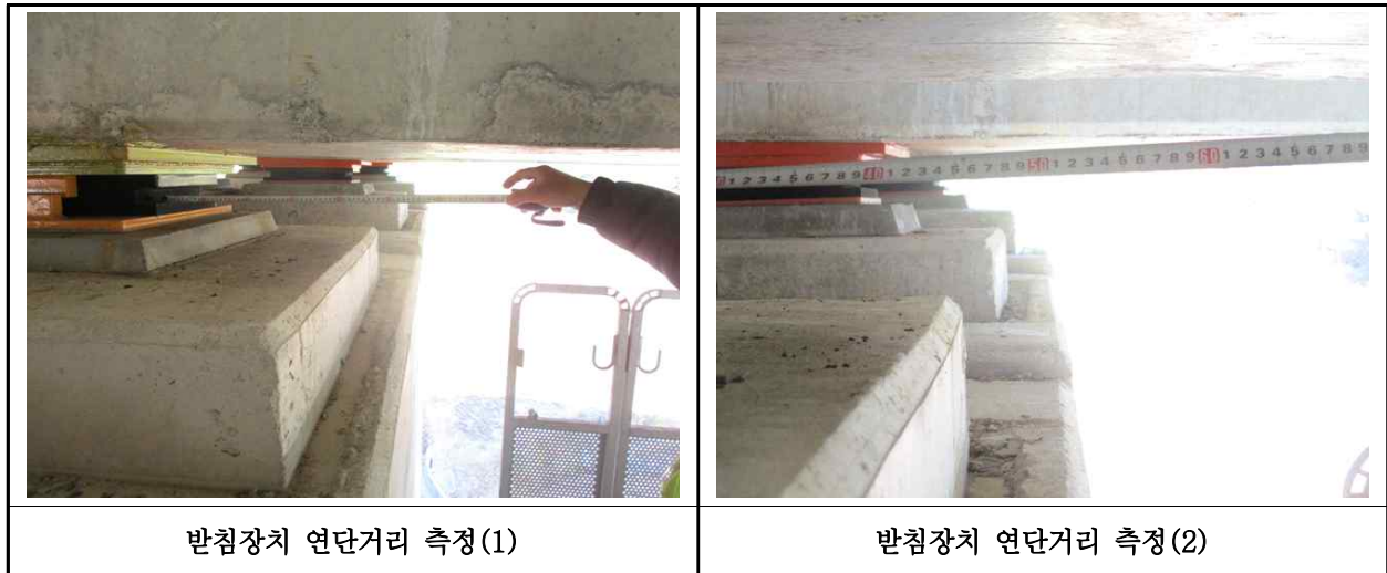
【사진 27.3.37】 교량받침장치 연단거리측정
