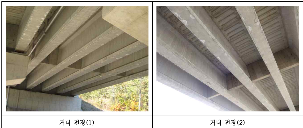
【사진 27.3.4】 거더 전경
