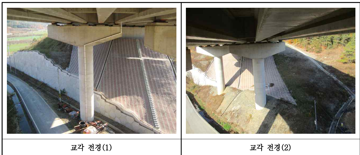
【사진 27.3.10】 교각 전경
