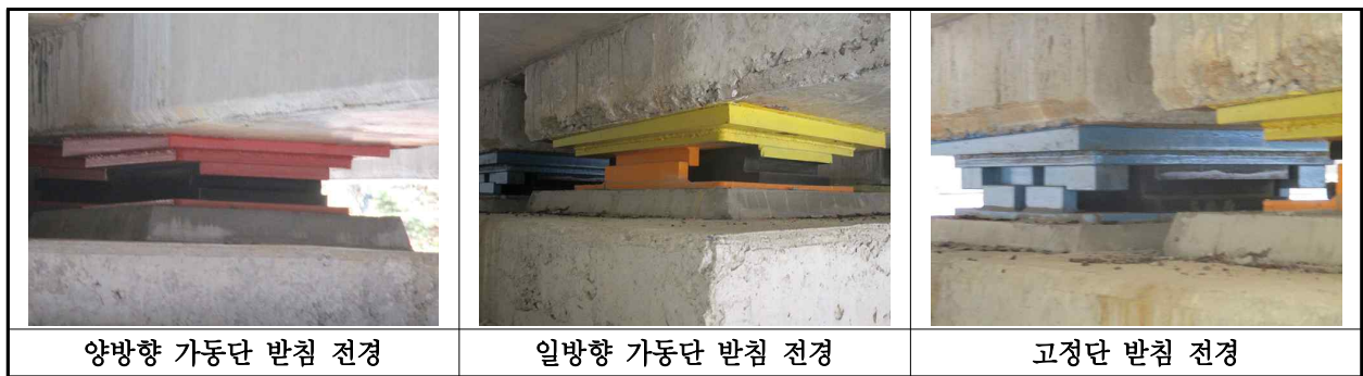
【사진 27.3.35】 교량받침 전경
