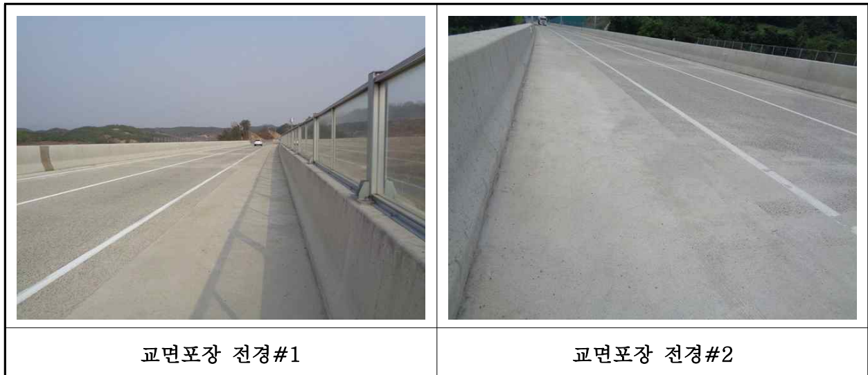
【사진 27.3.42】 교면포장 전경
